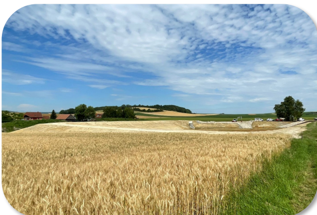
Fertigstellung Regenrückhaltebecken „Im Kreuzfeld“ in Kleinrötz
