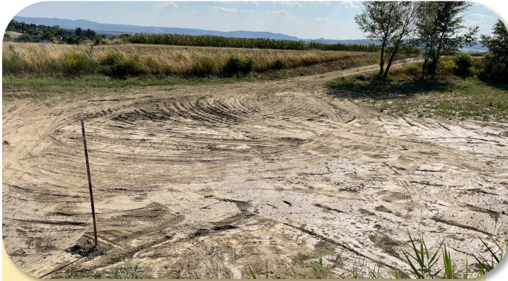
Instandhaltung des großen Regenrückhaltebeckens
