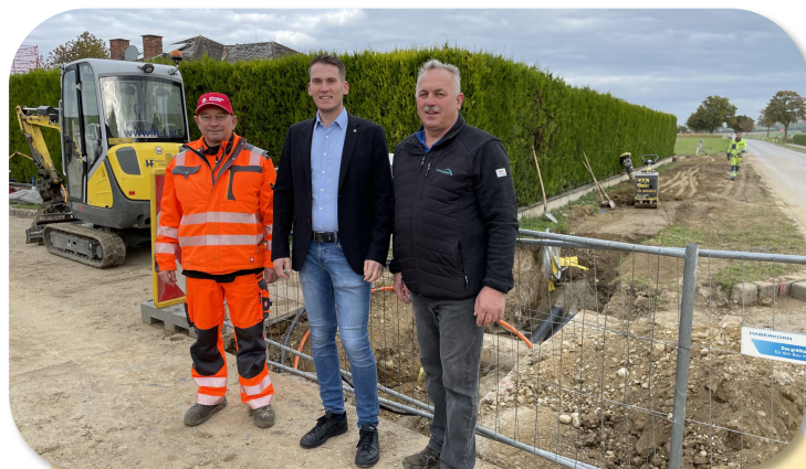
Ausbau der Infrastruktur (Wasserleitungsnetz usw.)
