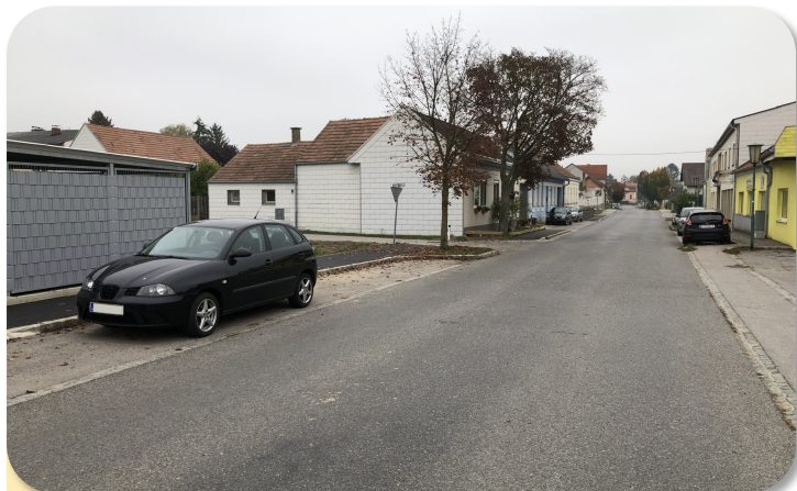
Errichtung eines Gehsteiges in der Harmannsdorferstraße (L1111) bei der neuen Wohnhausanlage
