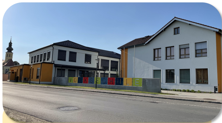
Bau der neuen Volksschule Harmannsdorf
