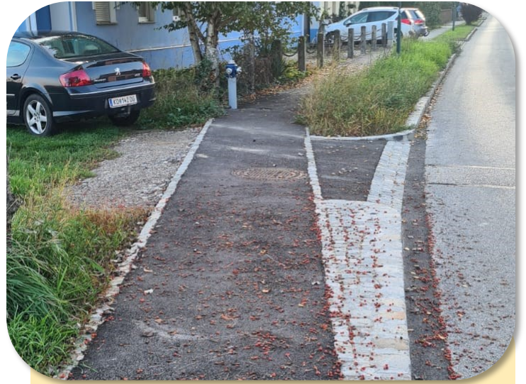
Verlängerung des Gehsteigs in Lerchenau
