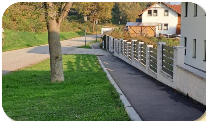
Umsetzung des Gehsteigs in der Haseneggstraße
