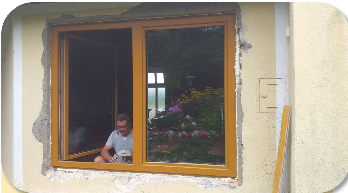
Montage neuer Fenster in der Kapelle
